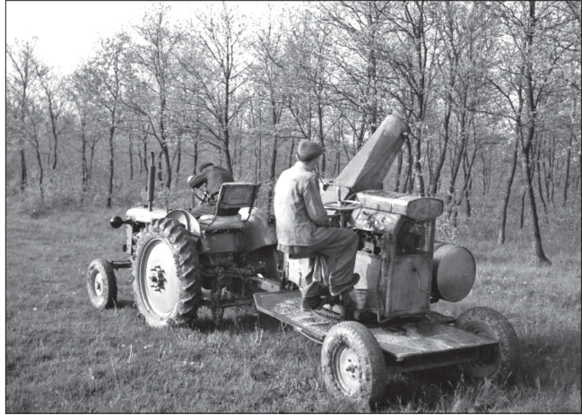
Traktorvontatású permetezőgép kísérleti alkalmazása a rajzó cserebogár imágók elleni védekezésben (Sopronhorpács, 1954). Az Erdészeti Tudományos Intézetben az 1950-es évek közepén Apt Ödön (1901–1990) folytatott ilyen jellegű kísérleteket. Eredményeit több közleményben ismertette. 1956-ben elhagyta Magyarországot, Kanadában telepedett le, az University of British Columbia magyar származású erdőmérnök hallgatóinak ő oktatta az erdővédelemtant (Forrás: SOE ERTI fotóarchívum)
