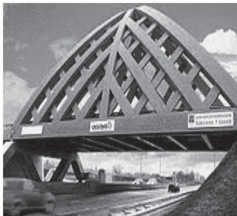
Fahíd Sneek Hollandia Kanada (tartók fesztávolsága 93,9 m) ( www.accoya.com/uk/project/accoya )
