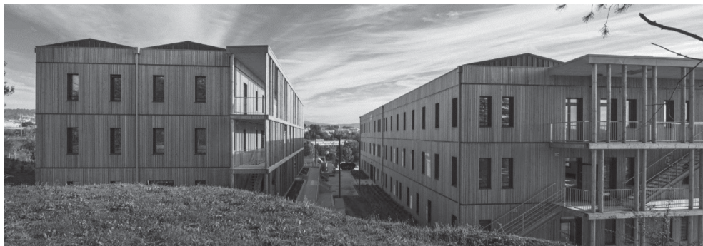
CLT technológiával épült házak Franciaországban ( https://www.construction21.org/articles/h/lensoleillee-efficient-building-of-the-green-building-solutions-awards-2014.html )
